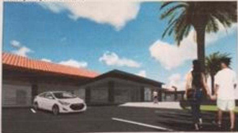
Acceso principal ambulatorio
